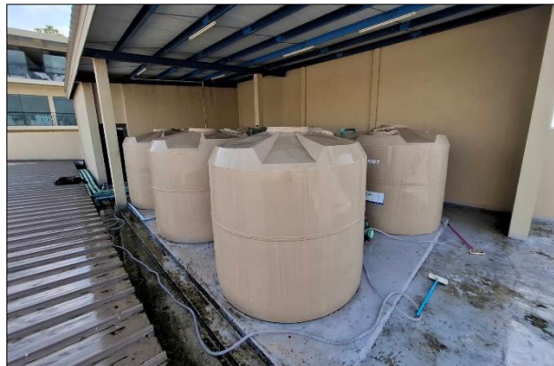
รูปที่ 3.1-1 ถังเก็บน้ำชั้นดาดฟ้า
